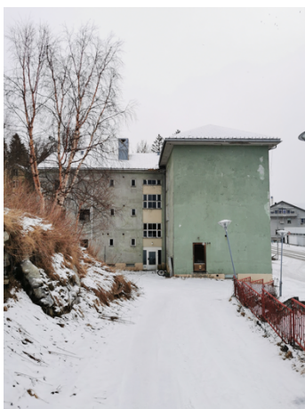
Vestgavl og bakre bygning
