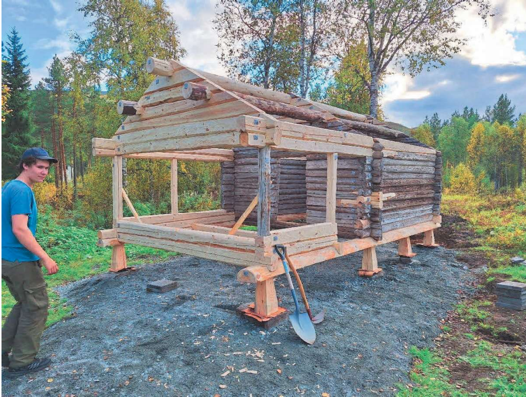
Figur 8. bygningskroppen kommet på plass
