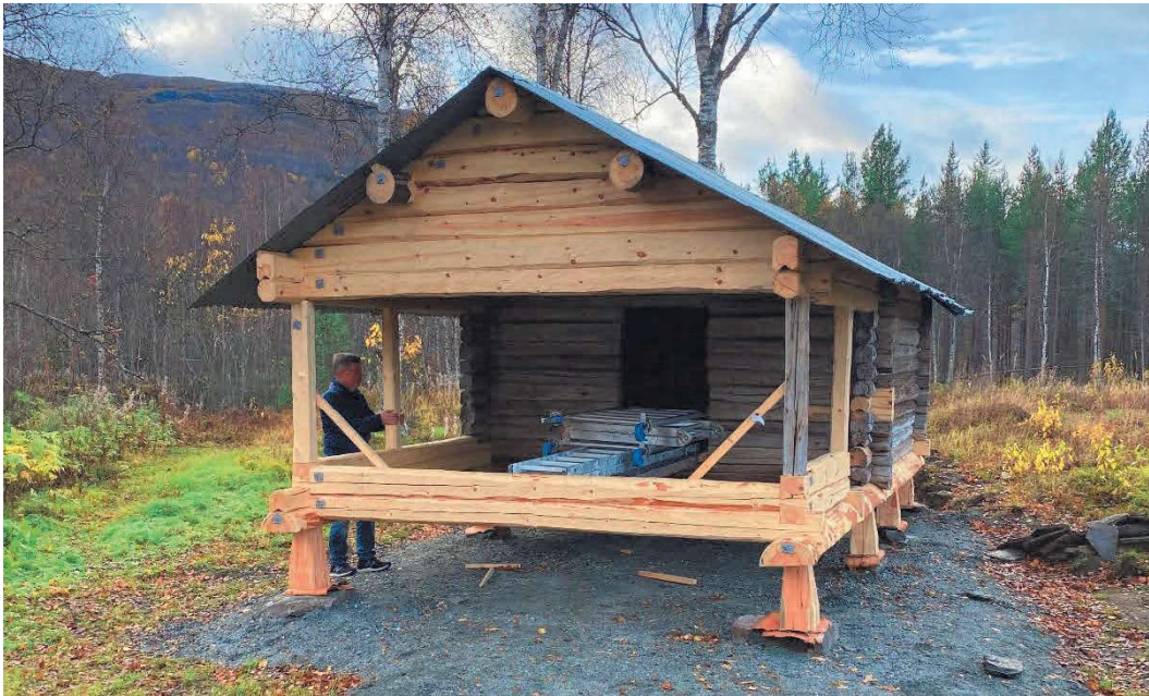
Figur 9. Åser og tak montert
