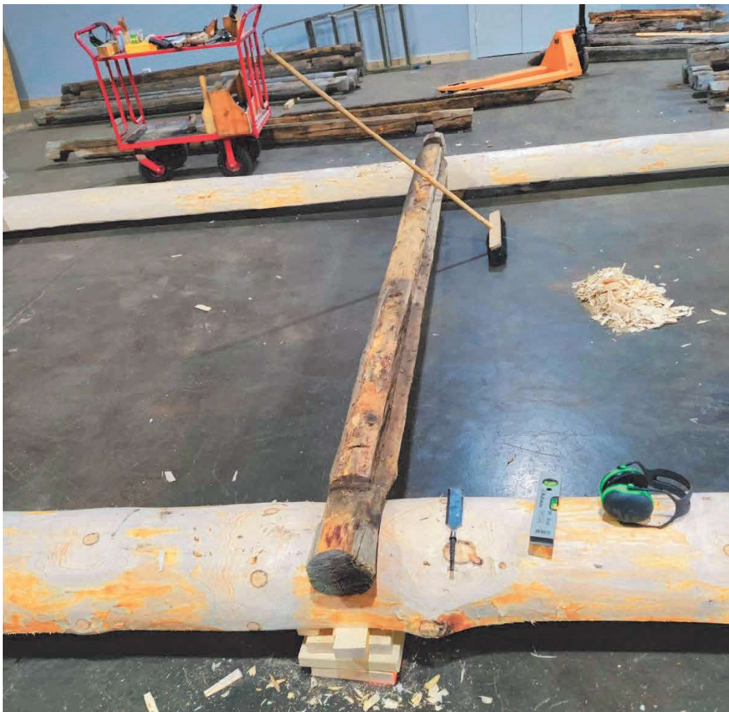
Figur 5. Tilpassing av gammelt laft til ny svill
