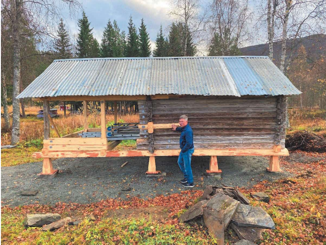
Figur 10. Taket på plass
