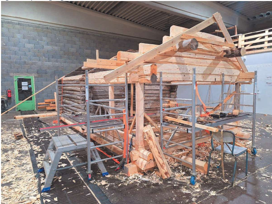
Figur 13. Røstene bygges i laftehallen
