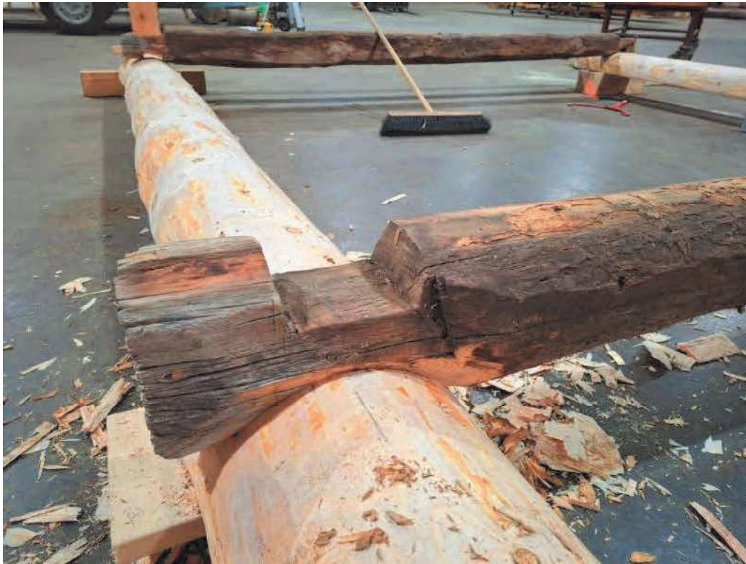
Figur 12. Tilpasning av gammelt tømmer
