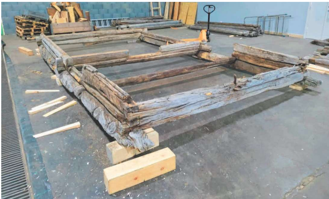
Figur 3. De nederste omfarene oppmontert i laftehallen
