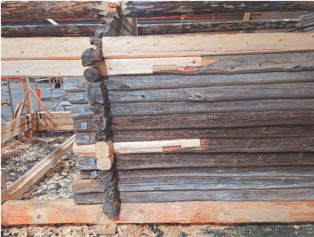
Figur 11. Detaljbile av spunsing på tømmerkassen
