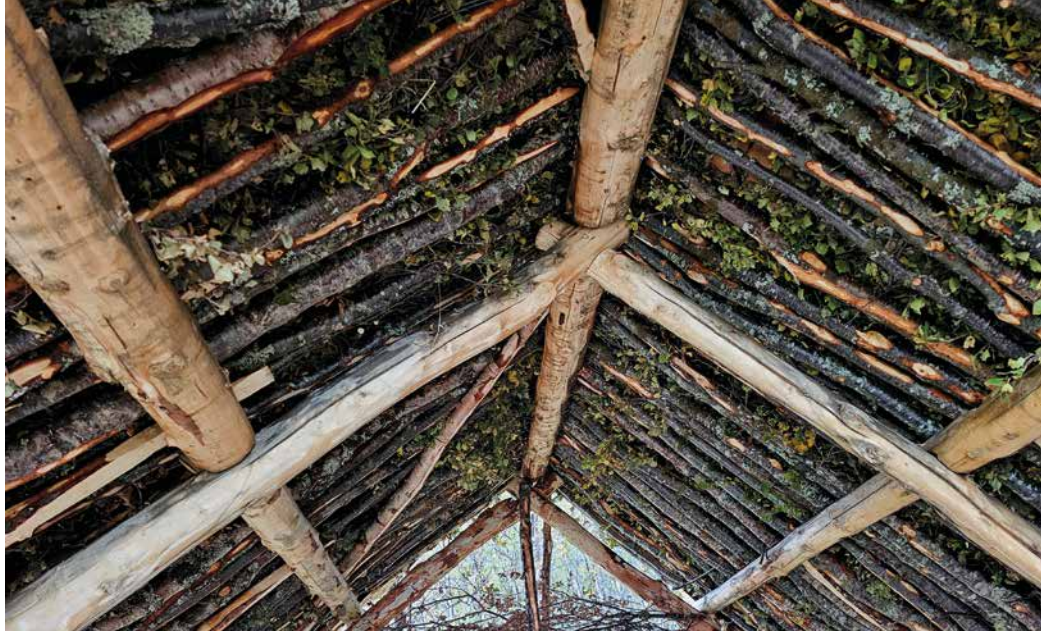
Den tradisjonelle nordnorske og samiske takkonstruksjonen fra undersiden med storsperrer, takåser, bjørkerajer, bjørkeris, never og torv. [Foto: Lars Børge H. Myklevold]
