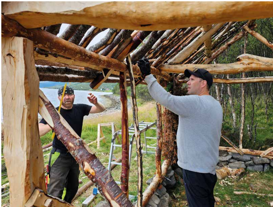
– Bremtroet må plugges fast, slik at endene på de løstliggende bjørkerajene kan hvile mot det. Det er vanskelig å finne rettvokst bjørk så langt ute på kysten, så vi valgte å felle noen graner til takåser. Så fikk vi også øvd på felling med øks. [Foto: Lars Børge H. Myklevold]
