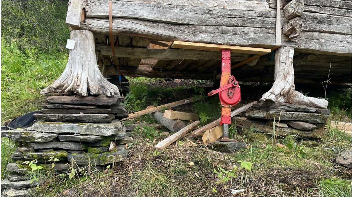
Bygget ble jekket opp for å justere steinfundamentet:
